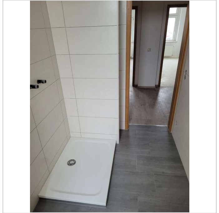
neues Bad im Bau
